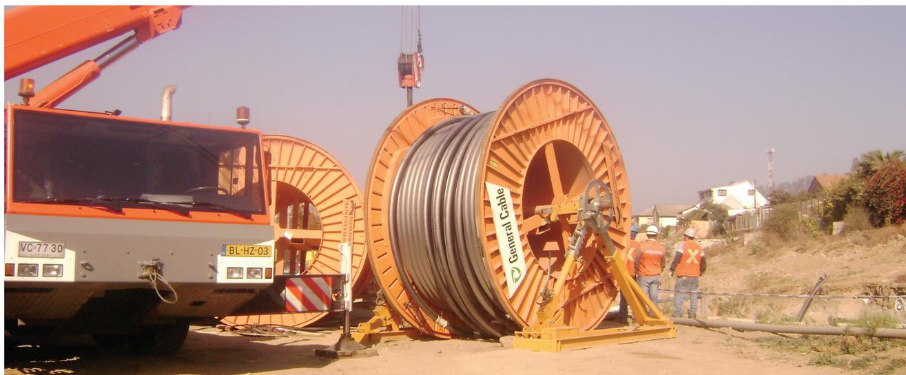
Instalación de cable de alta tensión bajo lecho del estero Marga-marga.
